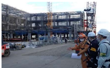
現場パトロールの状況
