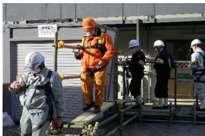
作業前に、全員が順に、フルハーネスの着用を確認し、徹底を図っている
