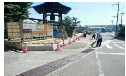
社内パトロール 現場周辺清掃の様子
