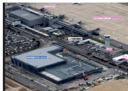
建設中(仮称)神戸空港サブターミナル
