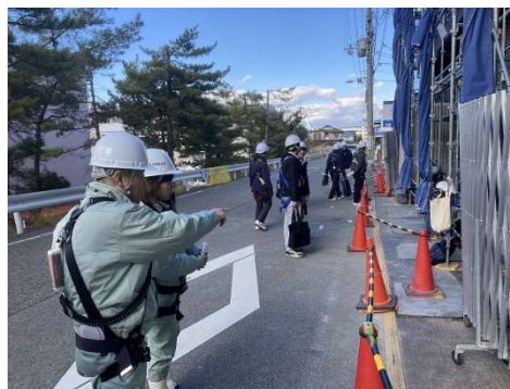
現場パトロールの様子
